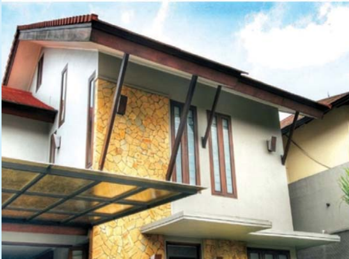
Gambar 1.9: Tiang Penyangga Atap Bangunan
