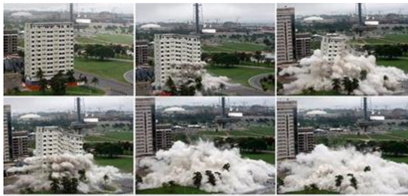
Gambar 1 Perobohan Gedung Dengan Peledakan (sumber: https://news.detik.com/berita/d-3225080 )
