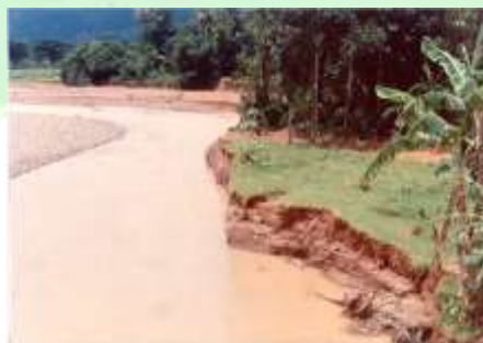
Gambar 27. Erosi di tebing sungai
