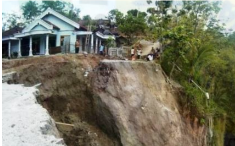
Gambar Tanah Longsor sebagai akibat pembangunan yang tidak memerhatikan daya dukung lingkungan.
